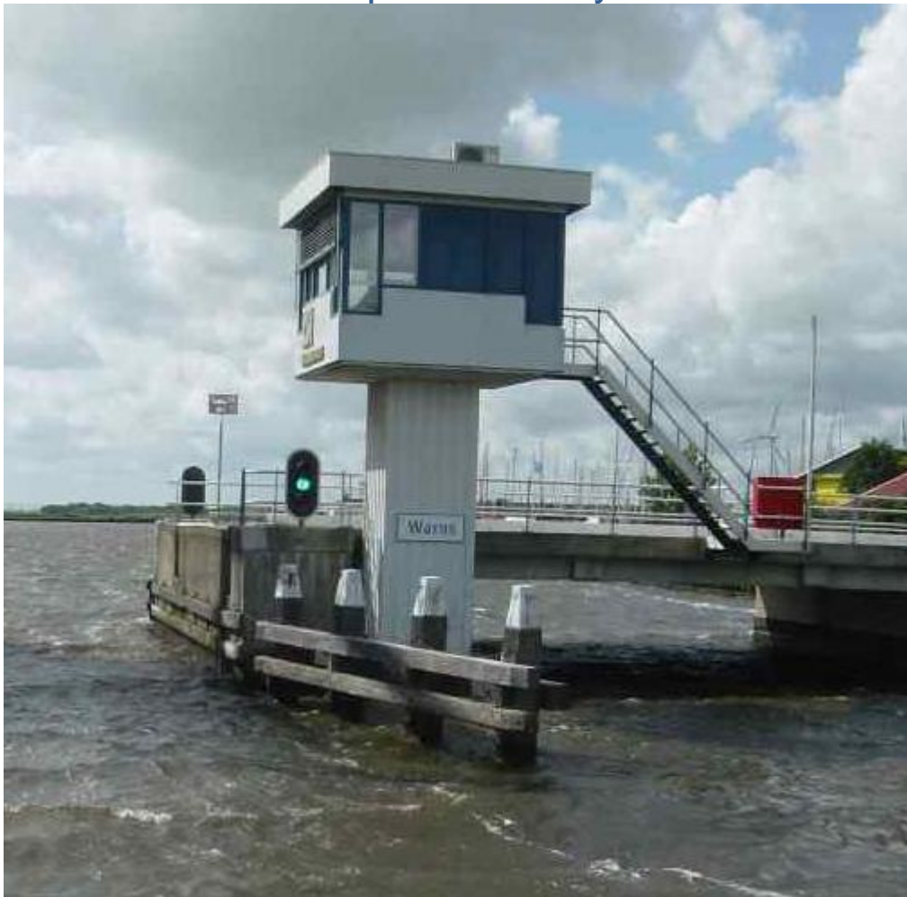
Foto: remmingwerken bij de brug te Warns.
